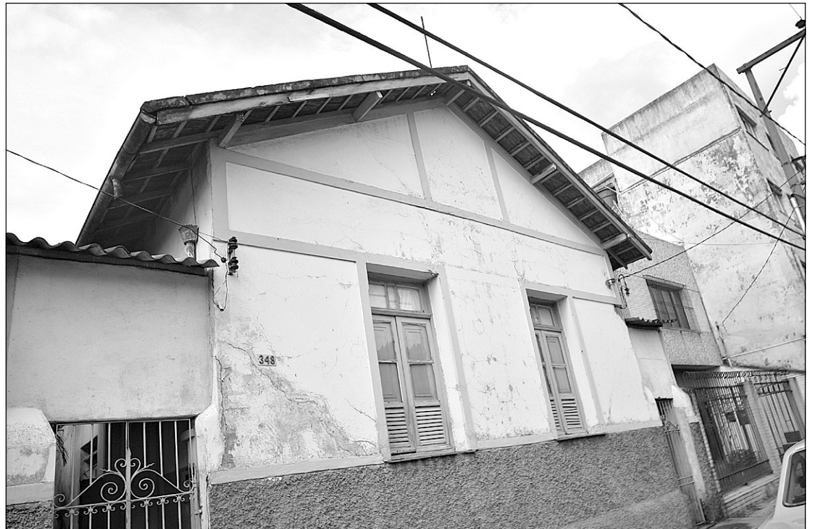
• Casa usada para aliciar menores possuía piscina, sauna, banheira de hidromassagem e mesa de sinuca
