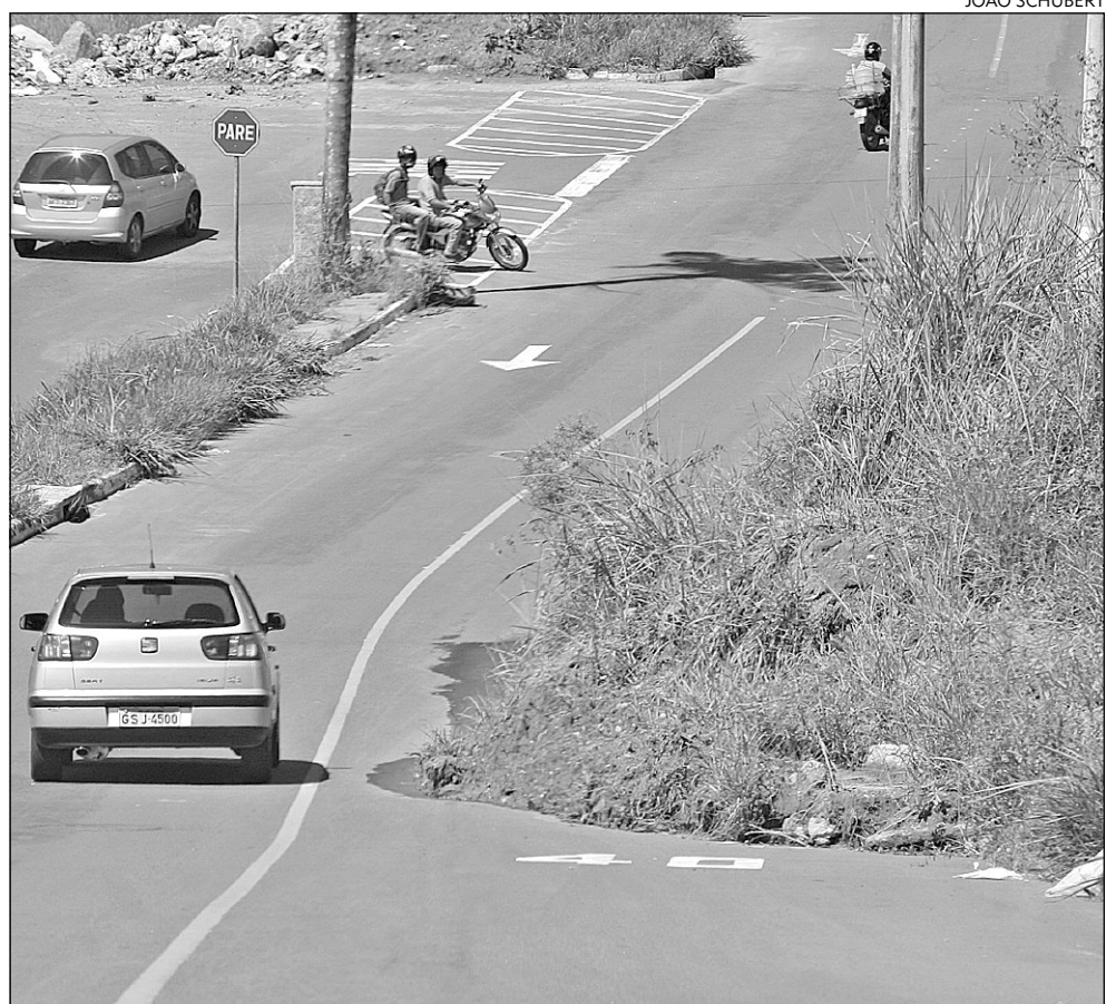
• Veículos são obrigados a ir para a contramão para desviar de barreira
